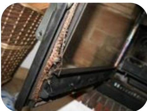
Les joints de vitre ne sont pas à changer fréquemment sauf, si vous avez utilisé des produits acides pour nettoyer la vitre. Dans ce cas, vous devez déposer la vitre en prenant soin de ne pas la casser, puis recoller un joint plat avant de refixer votre vitre.
